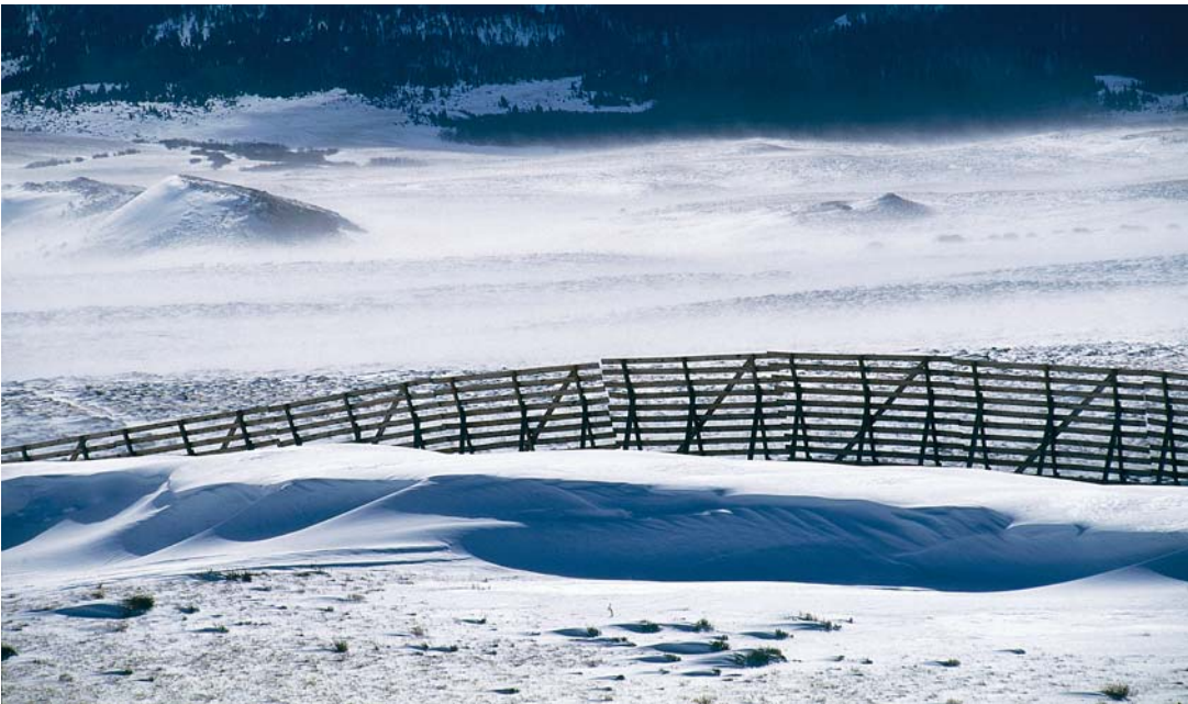
| 그림 6-18 | 방설책은 바람을 약화시킴으로써 눈의 수송 능력을 감소시킨다. 그 결과 방설책 앞쪽(바람을 맞는 쪽)에 눈이 많이 쌓이게 된다.(사진 : Stephen Trimble)
